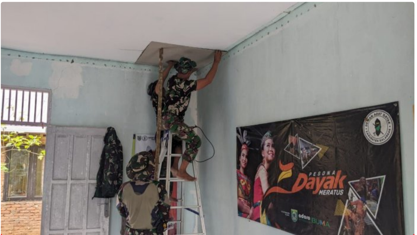
Kodim 1001/HSU-Balangan Rehap Kantor DAD Kabupaten Balangan
